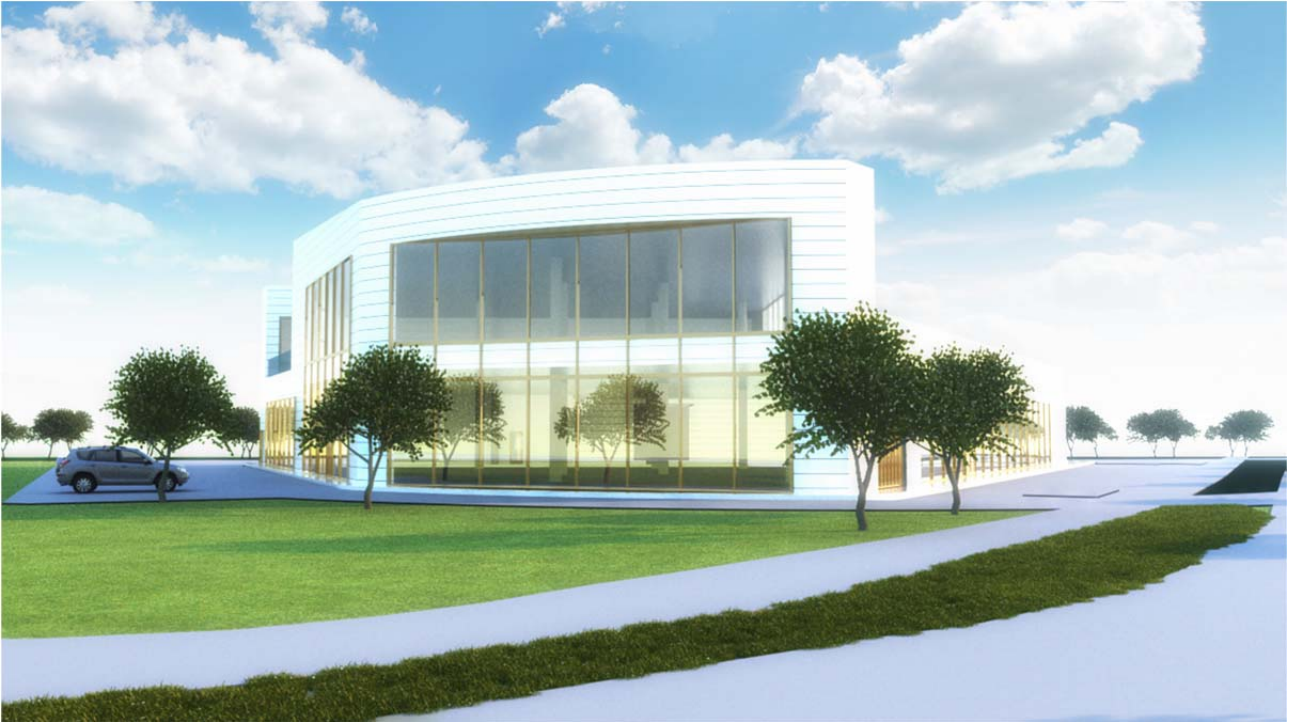
Figura 16: vista da sud-ovest
